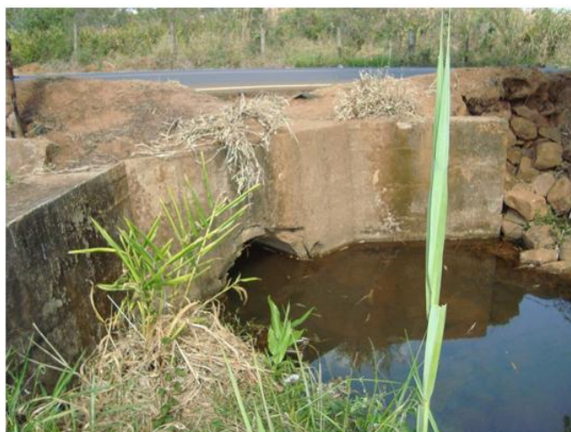
Figura 3.5.4-2: Bueiro de talvegue na Rua Clara Maria de Jesus (Córrego Taquaral) – Jusante
