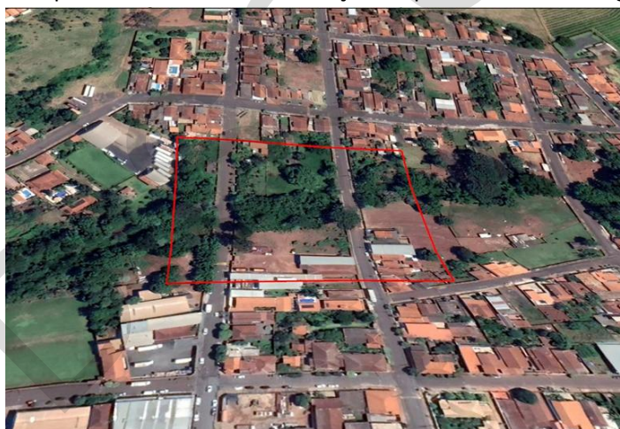
Figura 3.5.4.1-1: Exemplo de travessia com indicação de problema de drenagem
