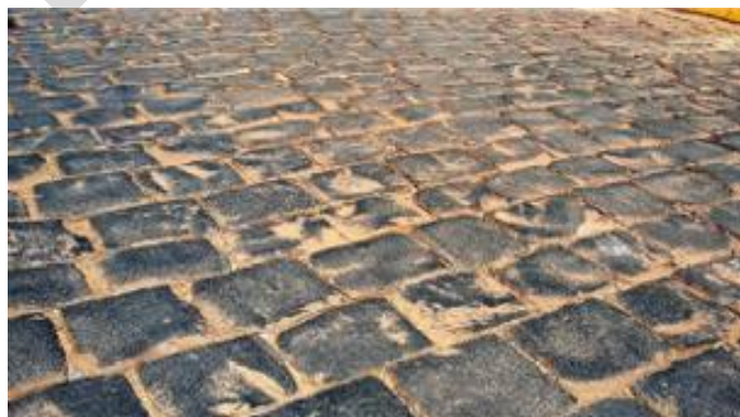
Figura 5.6-2: Ruas de paralelepípedos
