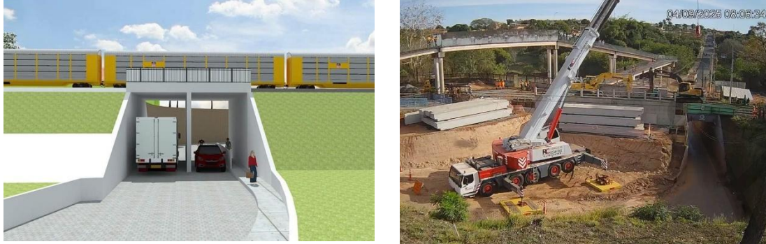
Figura 5.4.1-3 Projeto e obra de ampliação da interligação entre núcleos urbanos
